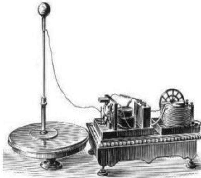
7 мая 1895 года на заседании Русского физико-химического общества А.С.Попов продемонстрировал свой первый в мире радиоаппарат для приёма электрических сигналов без проводов. Этот день стал днём рождения радио. Он сконструировал прибор, реагирующий на электромагнитные волны. Сначала приёмник мог «чувствовать» только атмосферные электрические разряды молнии. А затем, научился принимать и записывать на ленту телеграммы, переданные по радио. Лишь позже по радио смогли передавать голос и музыку.
