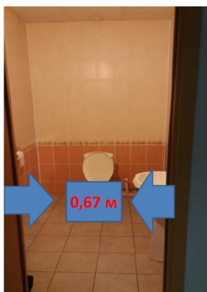
Туалетная комната на 1 этаже
